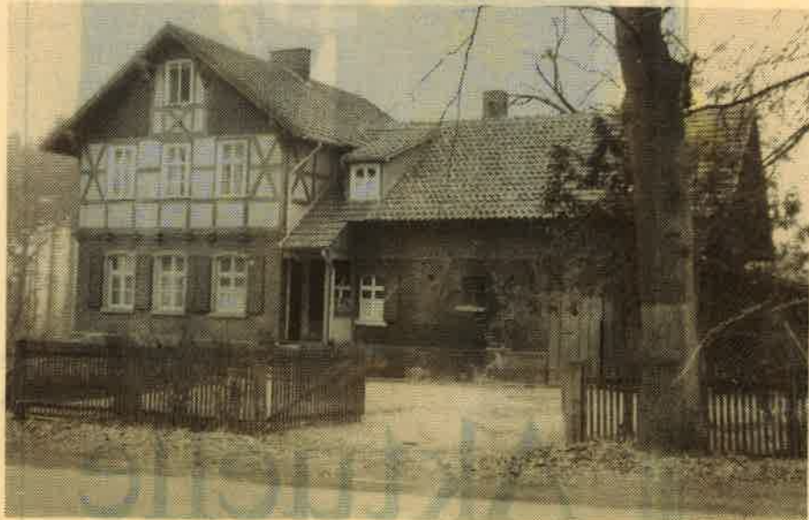
Das Forsthaus am Brand in alter Zeit: Durch den Ausbau der Bundesstraße 520 sind Vorgarten und Hof heute verschwunden. (Foto: nh)
